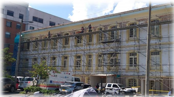
Intervención de fachadas
